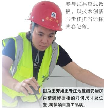
图为王芳娃正专注地复测安居房内精装修橱柜的几何尺寸及位置,确保项目施工质量。
